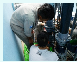
写真左： U-BCF実証実験機設置の様子
