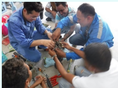
〈浄水場機器の補修技術指導〉
