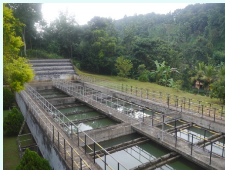
<現地の浄水場>
