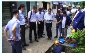
給水装置工事における施工監理能力向上プロジェクト
