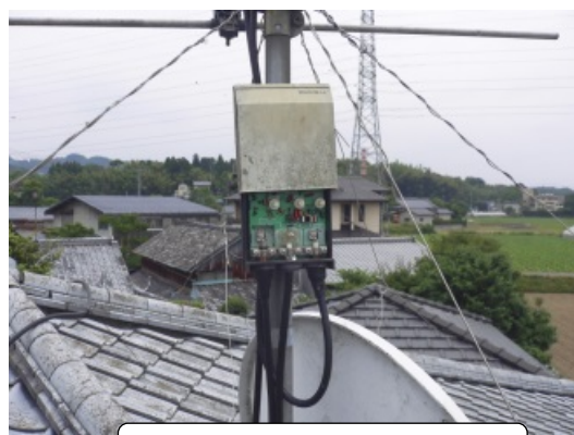
経年劣化したブースター
