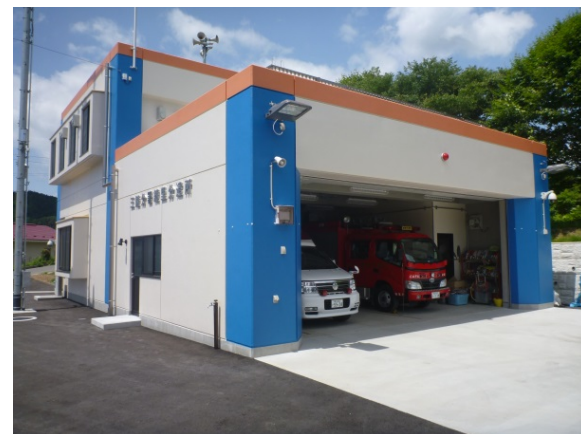
【消防庁舎復旧事業】
