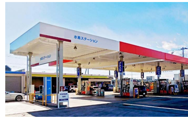
【水素ステーション】
