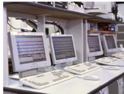
運用監視装置
