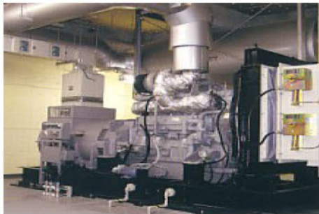
非常用発電機
