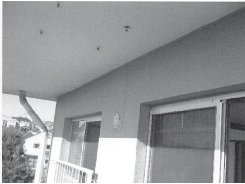
POFベランダエアコン 配管口引き込み (小さな隙間で配線可能)
