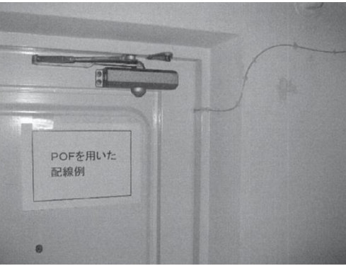
POF玄関扉引き込み (小さな隙間で配線可能)
