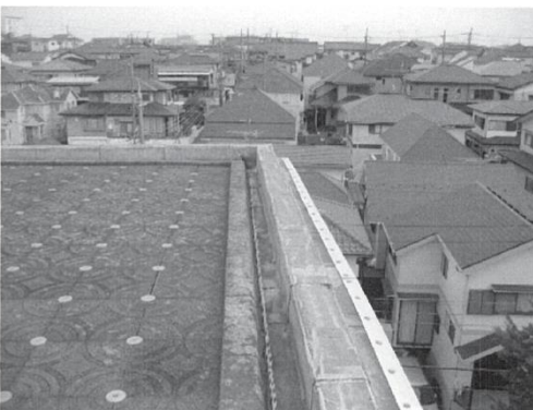
POF屋外配線(屋上面)
