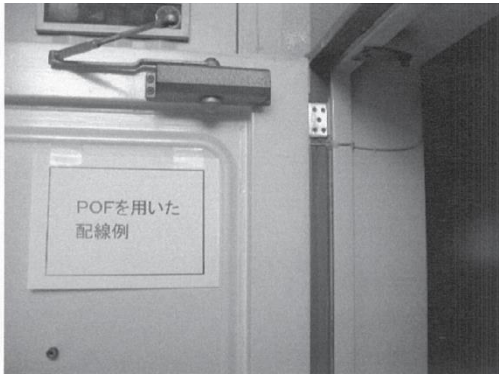
POF玄関扉引き込み (小さな隙間で配線可能)
