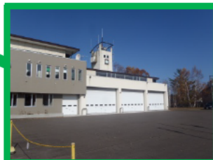
【弟子屈町役場川湯支所】
