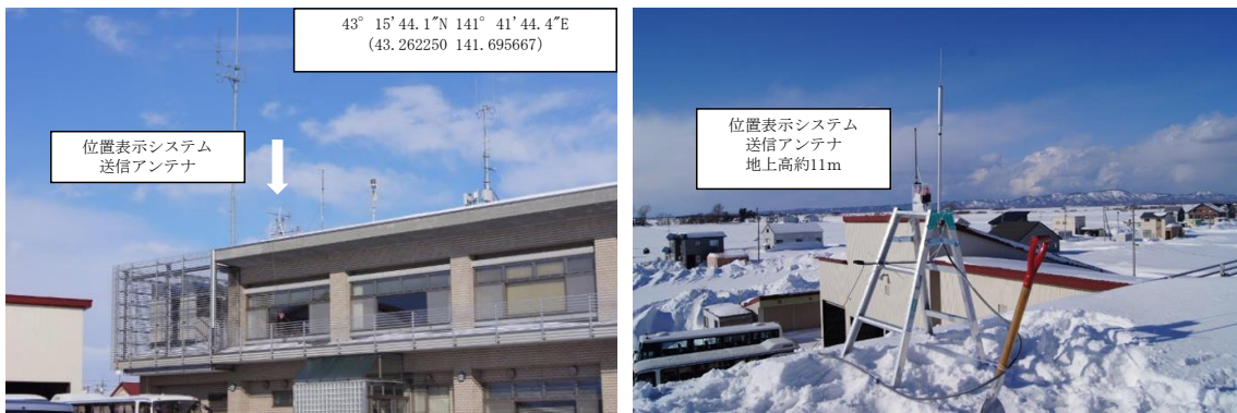
図 3-46 基地局（岩見沢市北村支所：空中線は地上高約 11m に設置）
