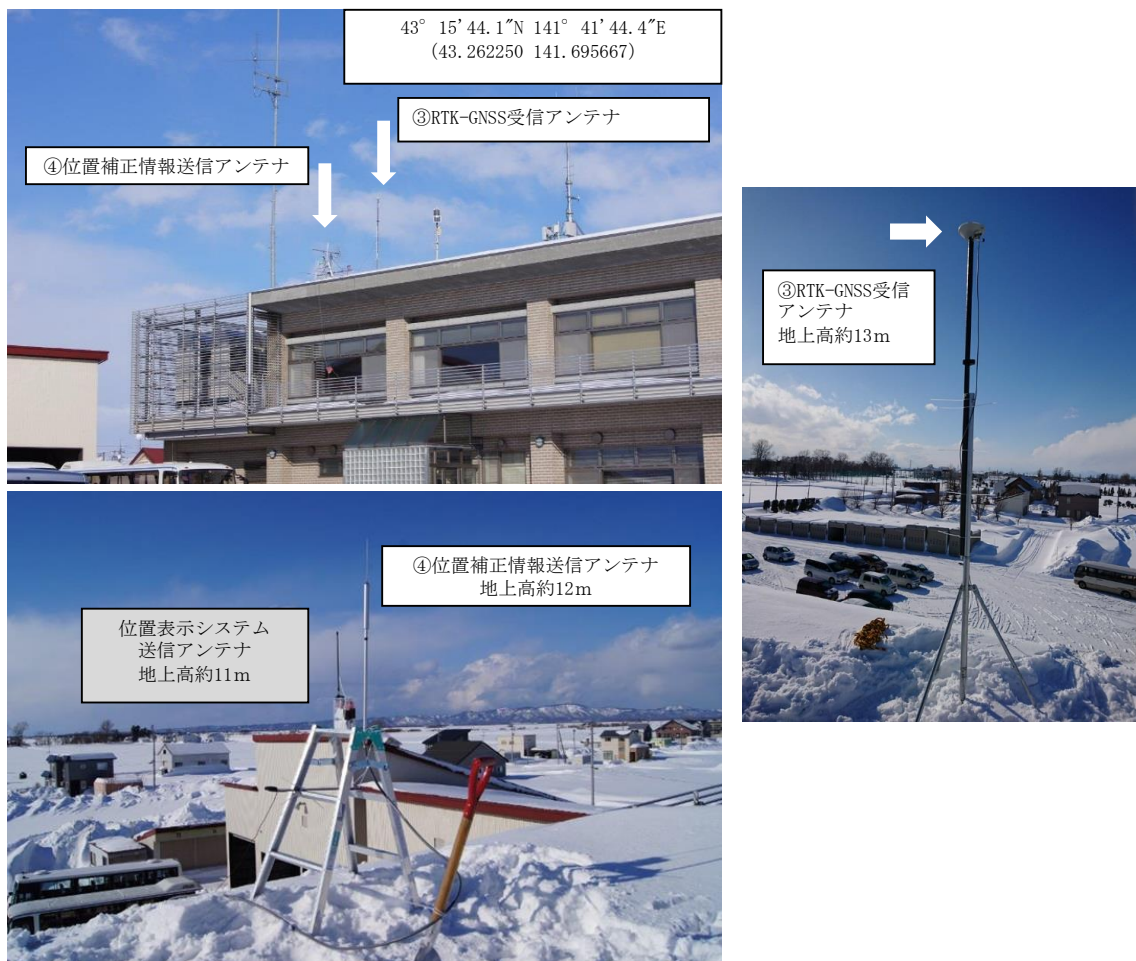
図 3-15 基地局機材（アンテナ設置状況）
