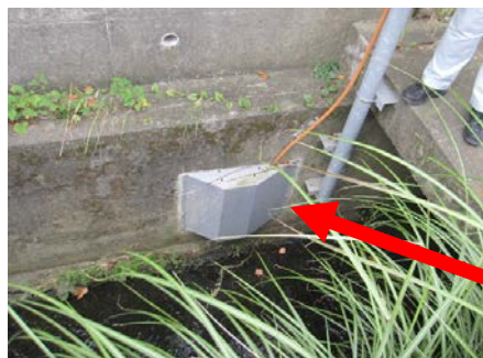
水位センサー設置 (例)
