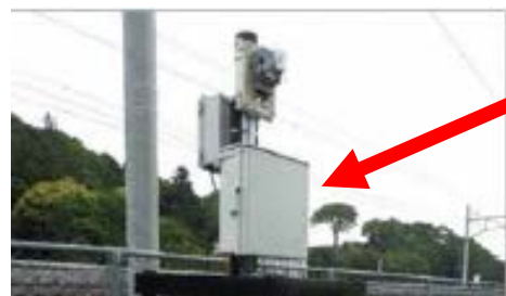
制御ボックス設置(例)
