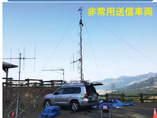
送信所のバックアップ設備
