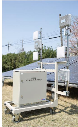
畜電池と組合せた設置
