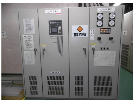
無停電電源装置設備
