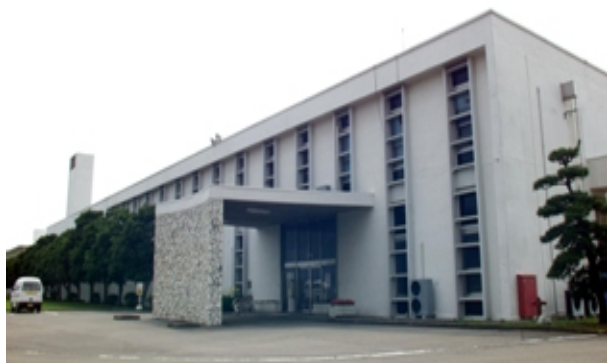
プルトニウム燃料第一開発室外観
