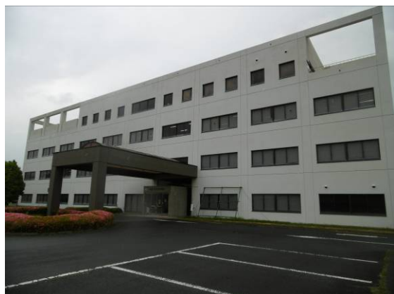
エントリー外観
