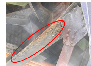
耐候性鋼材に層状の剥離
