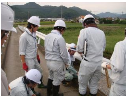
現場での点検方法の説明
