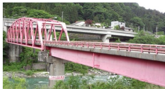
<音沢橋の状況>
