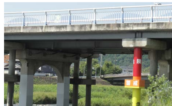
橋脚に注意、警戒、危険とペイントし、危険水位が一目で分かるよう工夫(多治見市内土岐川)
