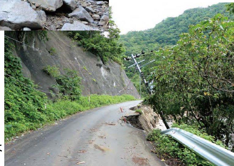
護岸の浸食により崩落した道路
