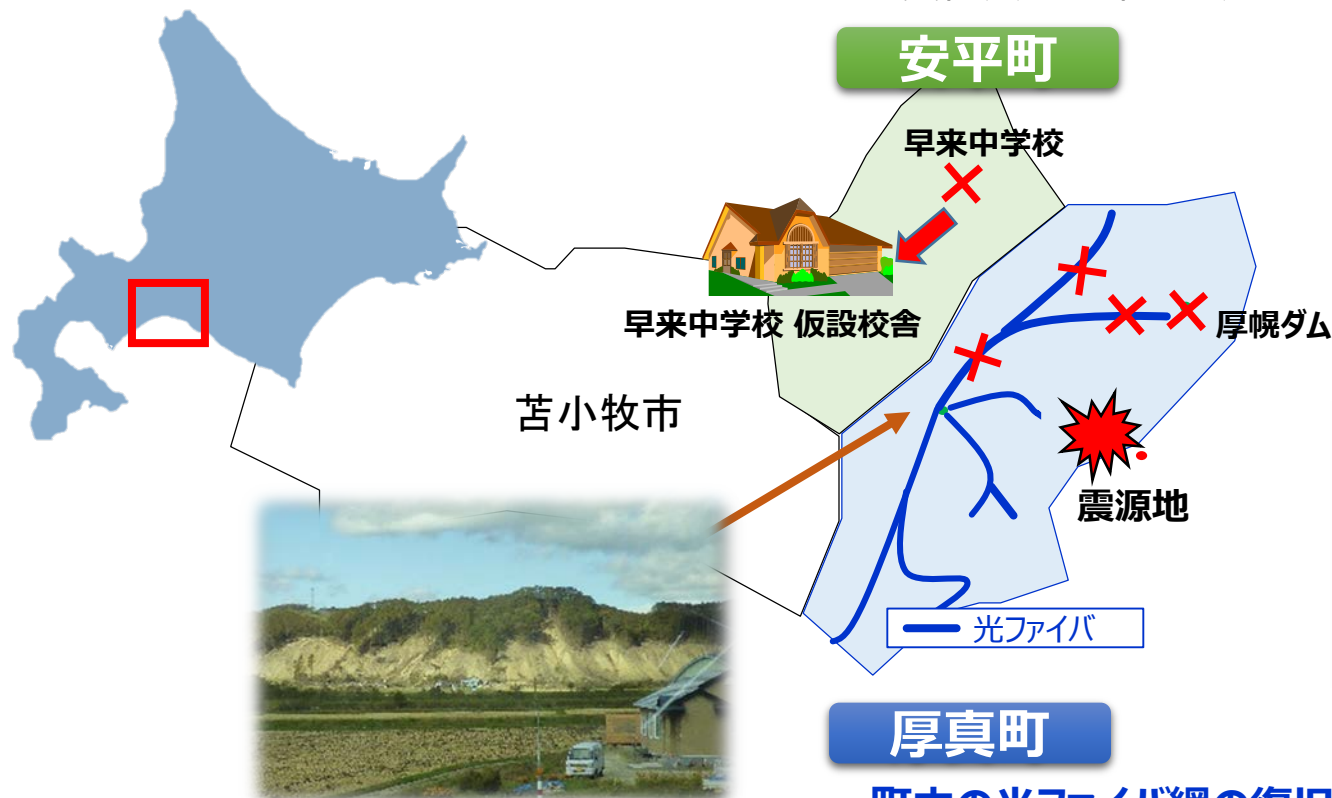
【厚真町】崖崩れによる光ファイバケーブル切断
