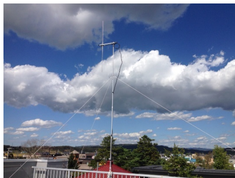
役場屋上に設置された 臨時災害放送局のアンテナ
