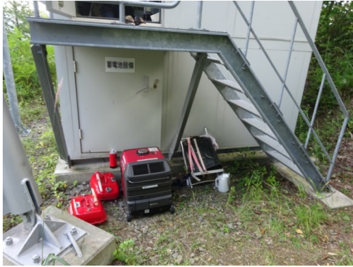
ポータブル発電機によるバックアップ状況
