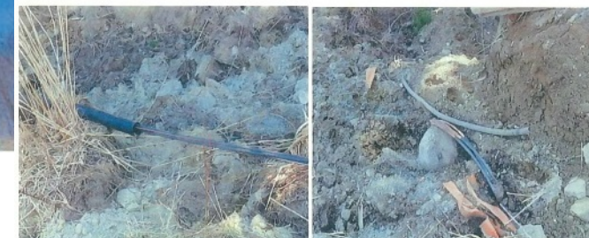
電力線 埋設配管 現状
