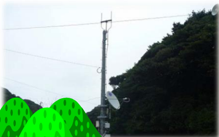
衛星回線を活用した基地局
