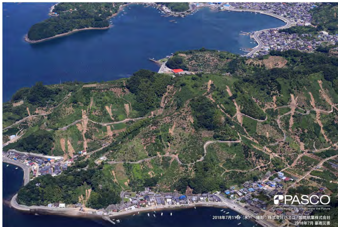
市内吉田地区における土砂崩れ。西日本豪雨により宇和島市内では約350か所(現在も調査中)以上の土砂崩れが発生し、柑橘園地に大きな被害が出ました。
