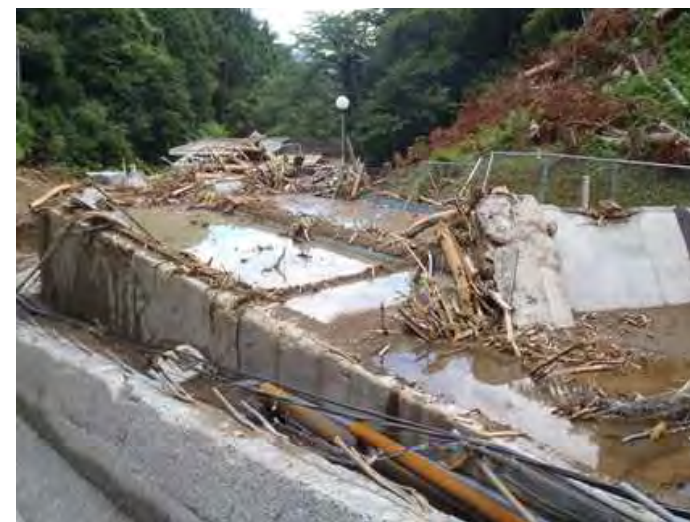
豪雨災害により土砂が流入して浄水場が破壊され、最大1万5千人以上の地域住民が1か月以上断水生活を余儀なくされました。
