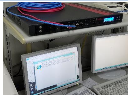
学校の設置状況 (2018.2.15-18)
