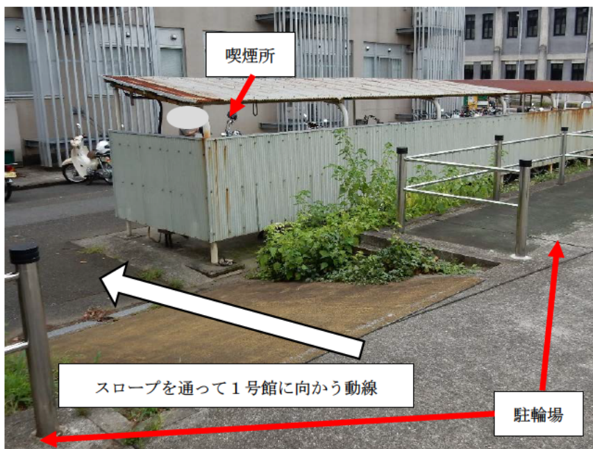
写真②ーイ (反対側) 駐輪場から理学部 1 号館に通じるスロープにも隣接している
