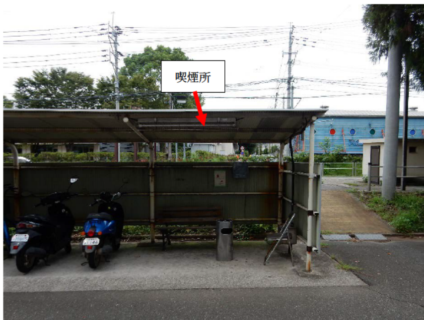
写真②ーア 屋根のある駐輪場の一部を喫煙所に指定している (理学部 1 号館北側駐輪場)
