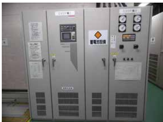
無停電電源装置設備
