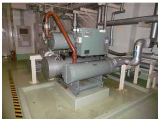
冷水・冷却水設備
