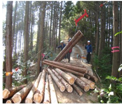
軽架線による搬出研修(和歌山みなべ)
