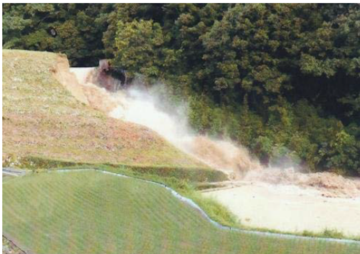
図表3 平成28年6月の豪雨により決壊したため池（広島県福山市）
