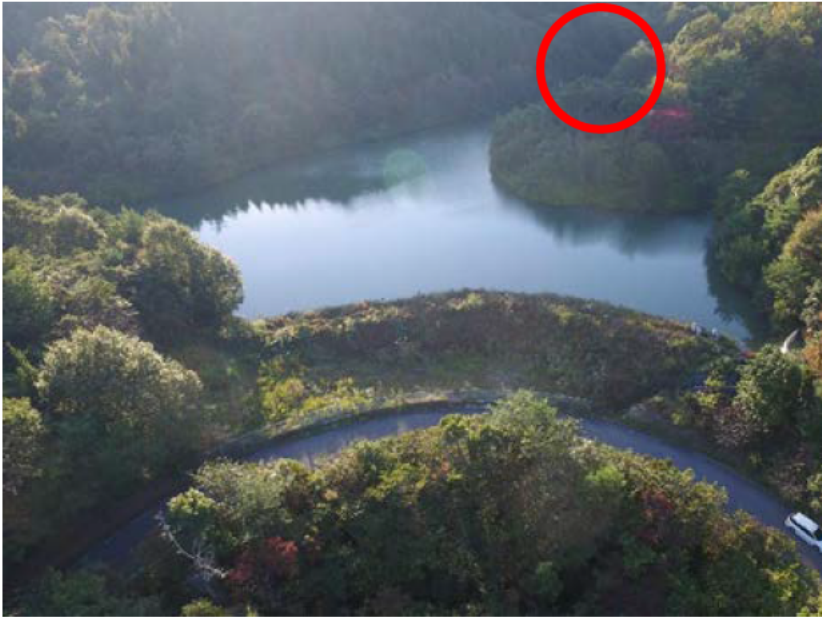
（A池の全景）※枠内の右岸で土砂の流入・堆積が発生
