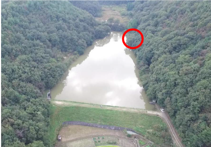
(C池の全景) ※枠内でため池への土砂流入が発生
