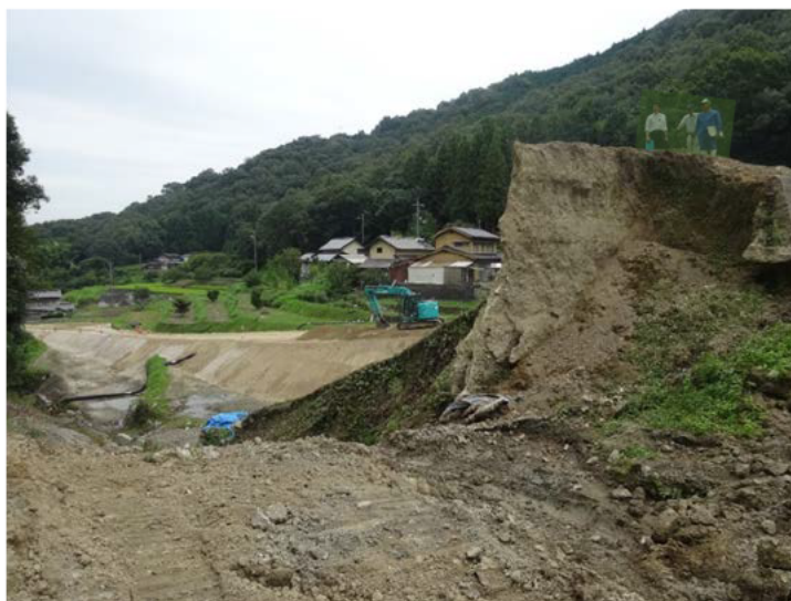
（破堤箇所の状況：平成29年9月11日）
