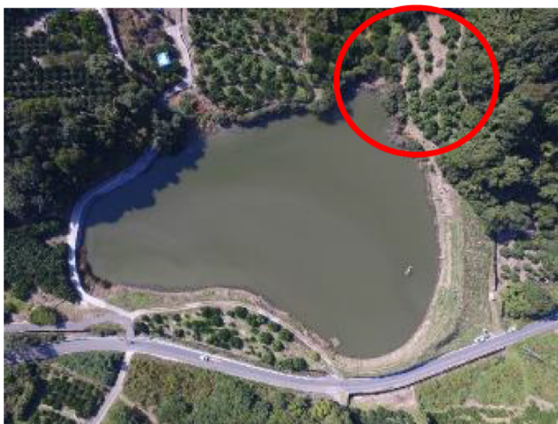
(B池の全景) ※枠内で斜面の土砂崩壊とため池への土砂流入が発生
