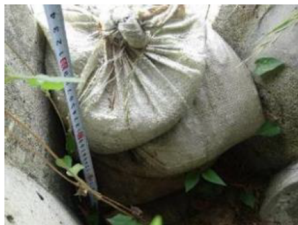
(洪水吐の深さ: 約 35cm、土のうの高さ: 約 25cm)
