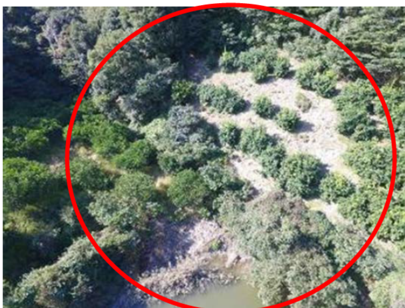
(ため池への土砂流入箇所と斜面の土砂崩壊の状況)
