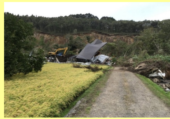
厚真町 土砂災害の被害状況 撮影:川崎市消防局
