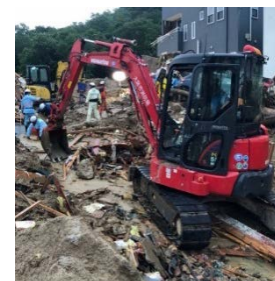
【重機によるガレキ撤去19 （広島県広島市）】
