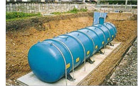
【耐震性貯水槽】
