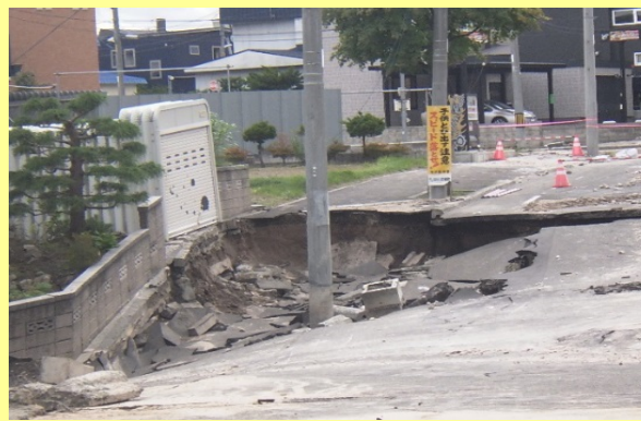
札幌市 液状化現象の被害状況 撮影:札幌市消防局
