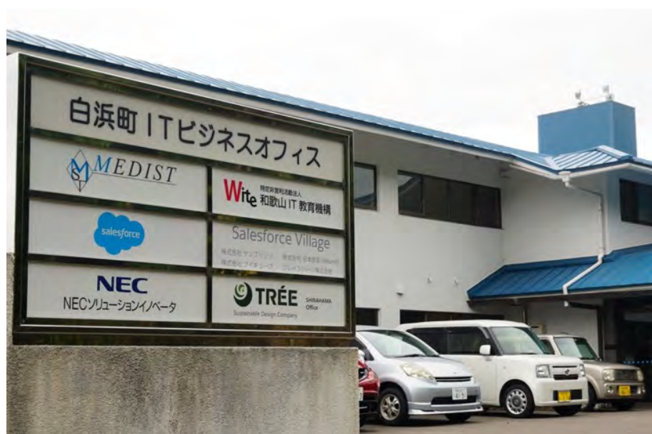
「白浜町ITビジネスオフィス」外観
