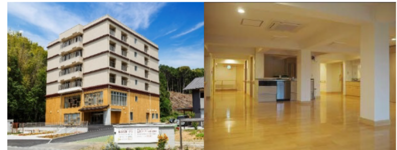
サービス付き高齢者向け住宅(高知県高知市)
