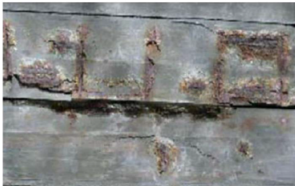
塩害による構造物損傷状況(橋梁)
