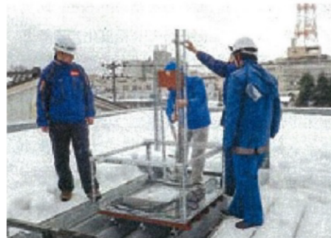
雪センサー取り付けの様子
