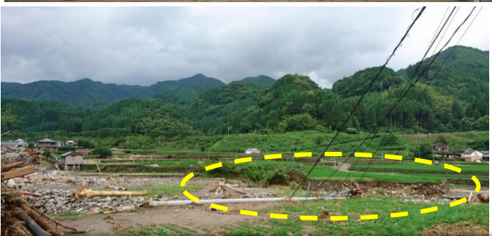
電柱が倒壊し通信線や電力線が断線
