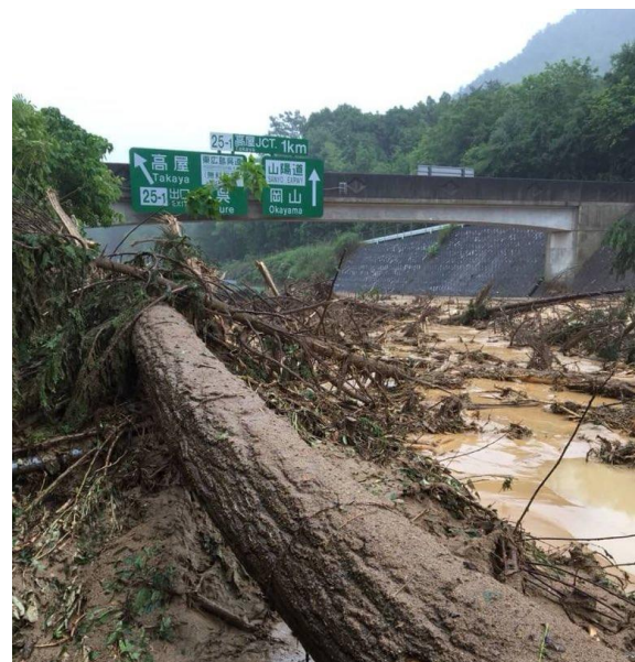
土砂が流入した 山陽自動車道
