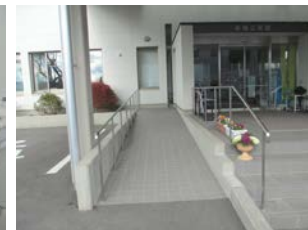
出入口の段差解消 事業費:30万円程度
