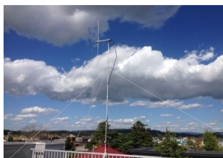
役場屋上に設置された臨時災害放送局のアンテナ
