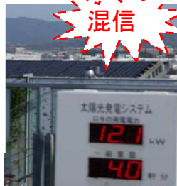
障害源の例 太陽光発電インバータ電子機器(イメージ写真)
