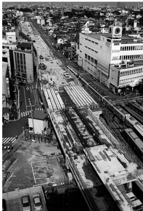
【複々線化工事が進む小田急線】
