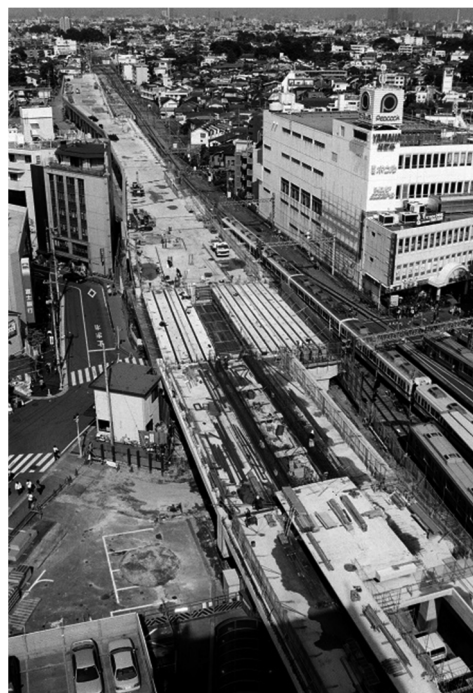
【複々線化工事が進む小田急線】
