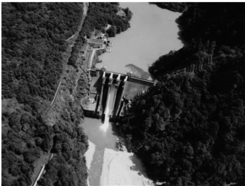
【排砂中の出し平ダム】
