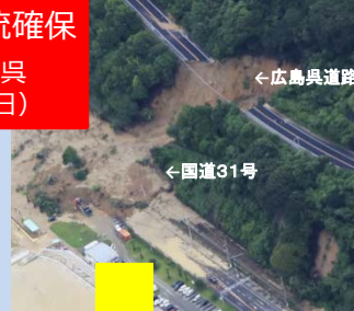
国道31号 (坂町水尻)
