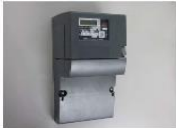
電力スマートメーター
