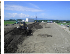
ICTバックホウによる層毎の高 さ設置等により作業を効率化 【田中産業(株)】
