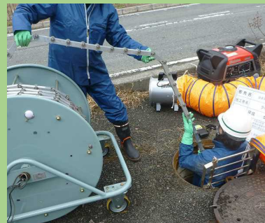
下水道管路点検支援技術
