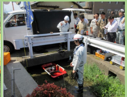
橋梁点検支援技術(狭小部)
