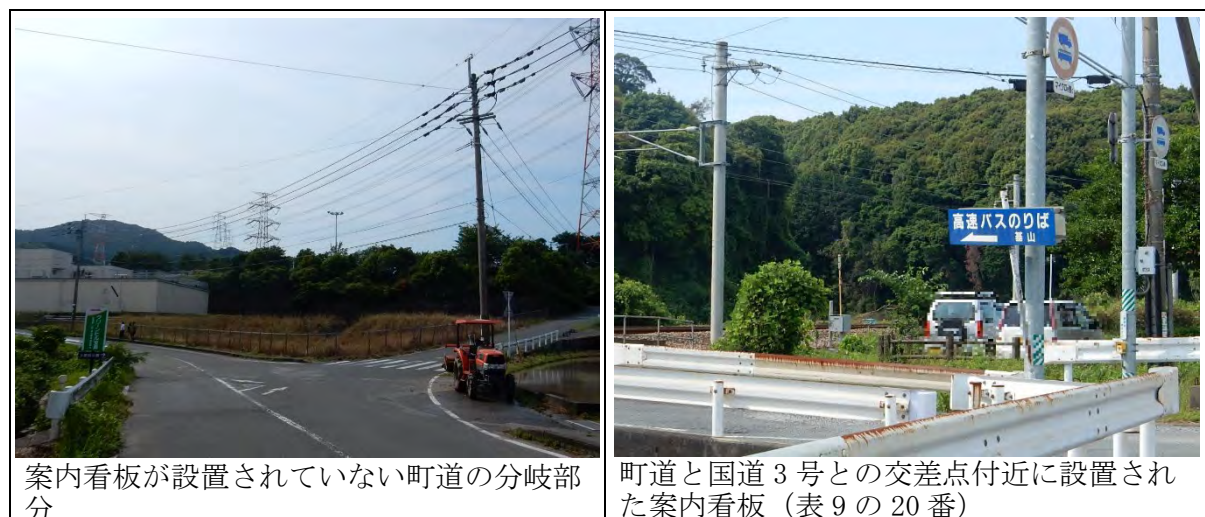
図 10 基山 PA への分岐等の案内看板の設置状況
