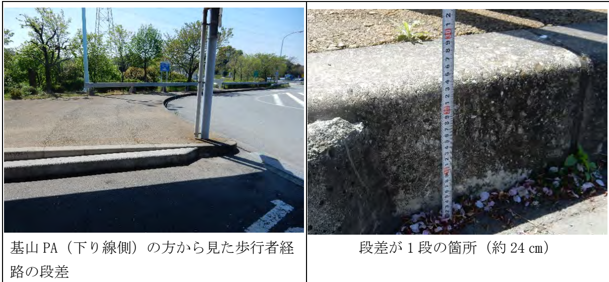
図3 歩行者経路上の段差の状況
