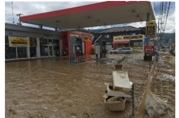
【平成30年7月豪雨におけるガソリンスタンドの被害事例】
