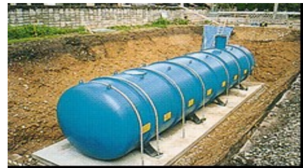
【耐震性貯水槽】
