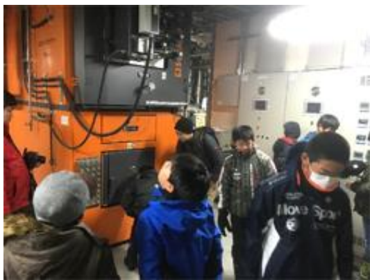
一の橋地区バイオマスボイラー
