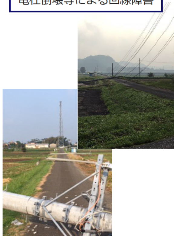
電柱倒壊等による回線障害
