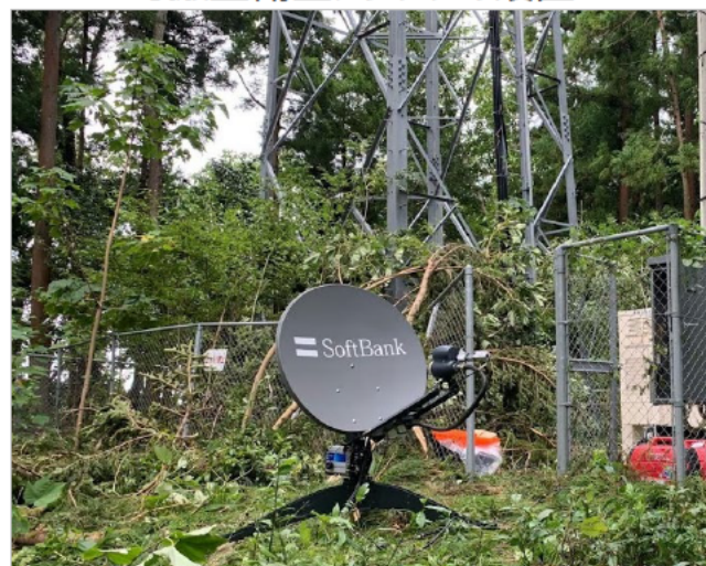
可搬型衛星アンテナの設置
