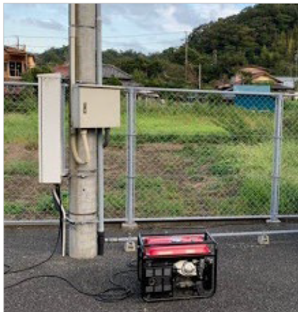
可搬型発電機による給電
