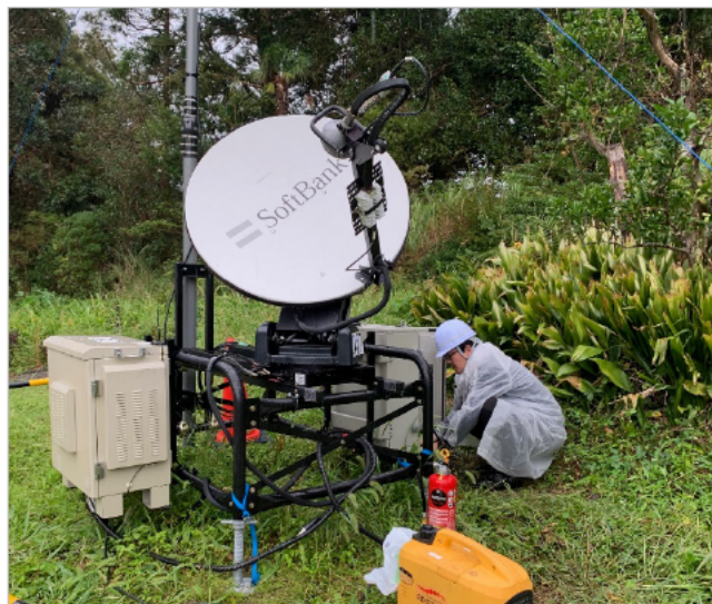
可搬型衛星アンテナの設置
