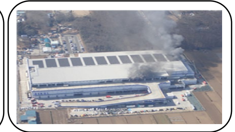
建物火災 (入間東部地区消防組合消防本部提供)
