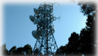
防災行政無線設備の被災
