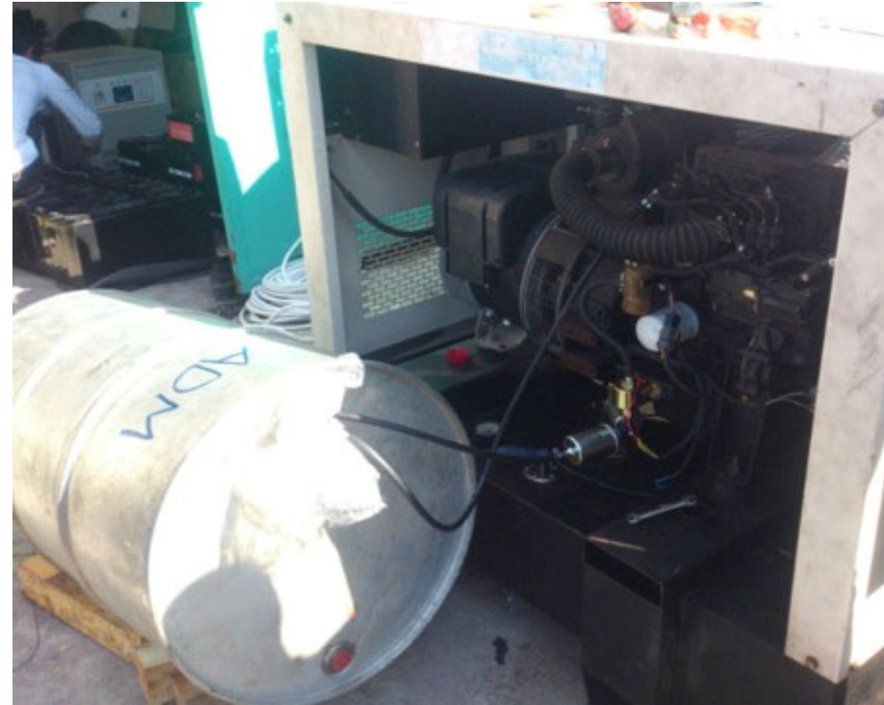
携帯電話事業者の発電機
