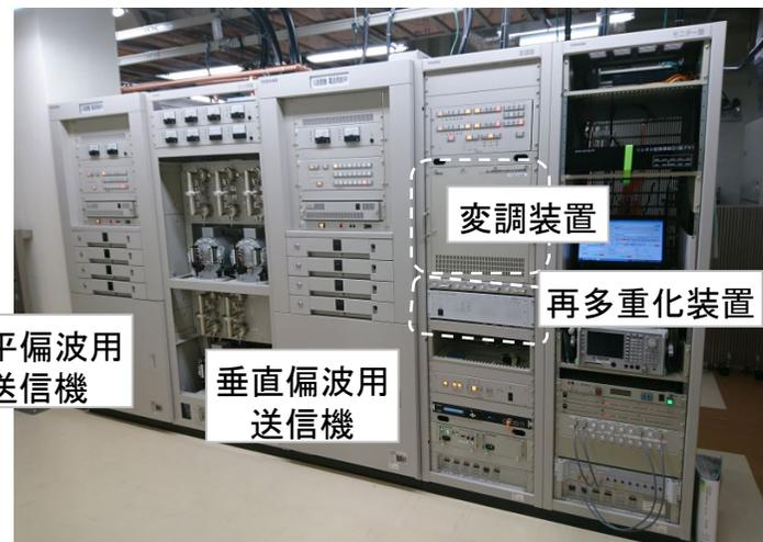
送信機・変調装置・再多重化装置
