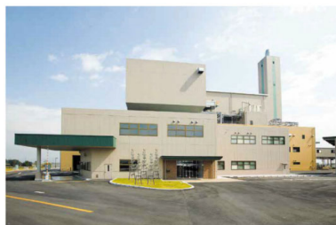
西濃環境保全センター(溶解炉)
