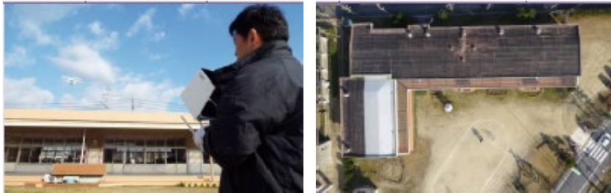
左:ドローンを活用した現況調査の様子 右:ドローンからの撮影画像
