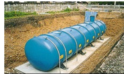
【耐震性貯水槽】
