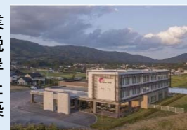
宿泊施設外観 (陸前高田市)
